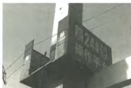
焊接操作平台
