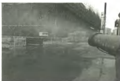
易起尘作业面 100% 湿法施工
