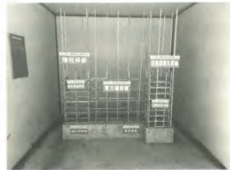
墙柱钢筋样板
