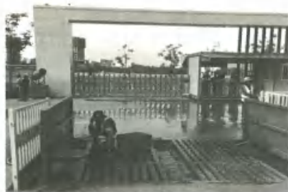
出入口 100% 安装冲洗设施
