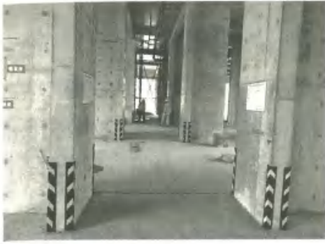
混凝土成活面
