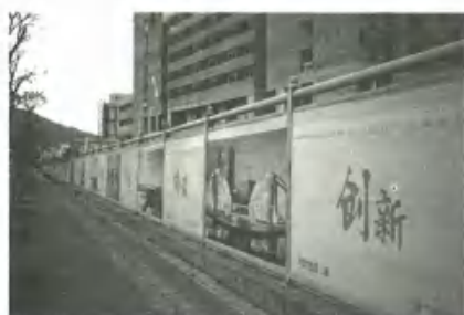
施工围挡及外架 100% 全封闭
