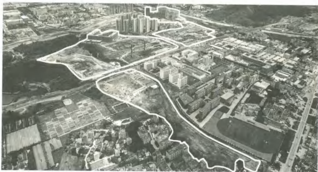
图4 深圳技术大学（一期）施工过程整体航拍图
